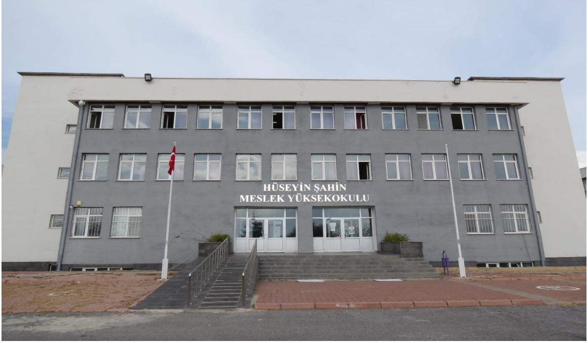
Develi Hüseyin Şahin Meslek Yüksekokulumuzun ön cepheden görünümü
